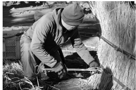
写真7 屋根針を用いて竹を藁に縫い留める
