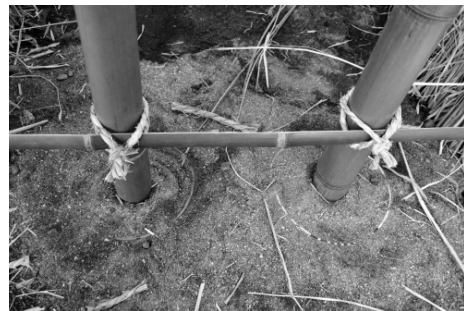
写真21 土中に埋められた管と骨組みの丸竹
