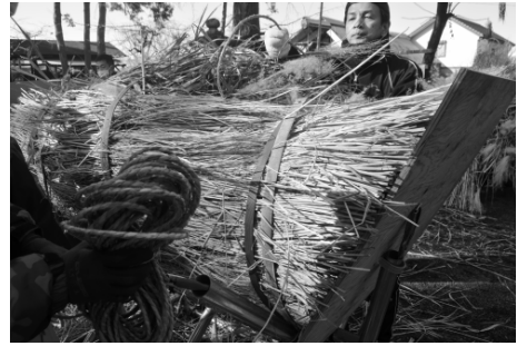
写真5 茅を芯にした藁束を縛り円筒形に形作る
