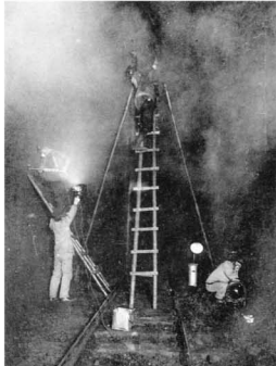
「中央線電化記念写真帖」に掲載されたトンネル内の電線取り付け工事写真（当館蔵）
